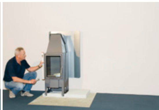
Installer l'insert de cheminée avec un niveau à bulle
