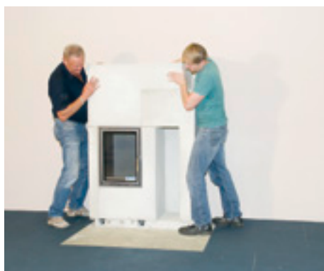
Assembler et coller les éléments d'habillage pièce par pièce et les peindre
