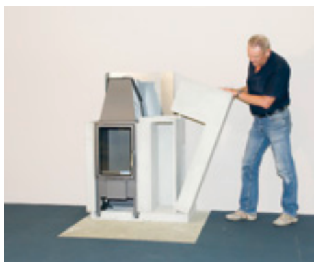
Assembler et coller les éléments d'habillage pièce par pièce et les peindre
